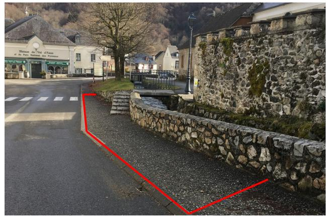
Une partie du revêtement du trottoir situé devant l'église d'Arrens est détériorée : elle va être refaite avec la même technique du béton lavé.
